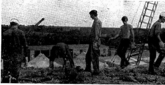
Органики на укладке керамзита.
