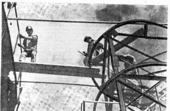
«А мы монтажники-высотники...»
